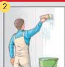
2 Utiliser colle classique papier peint épais sur le mur
